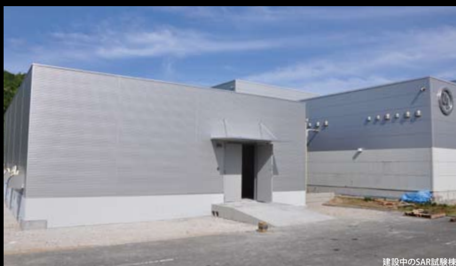
建設中のSAR試験棟
